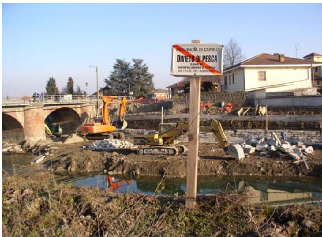
Figura 35: Varaita. Rimodellamento dell'alveo a Polonghera, in zona di ripopolamento
