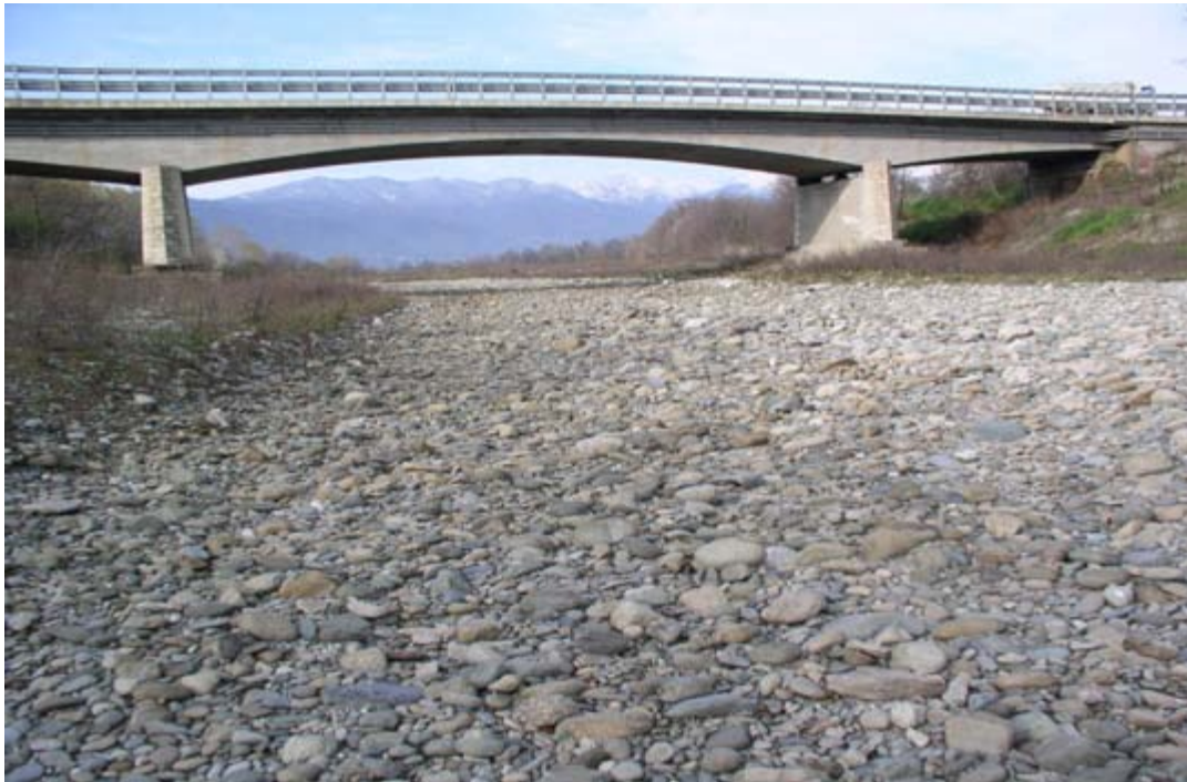
Figura 19: Po al ponte Saluzzo/Revello
